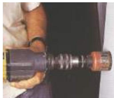
3. Após a perfuração pela face, segue-se a perfuração que será feita pelo rebordo de 2,5 mm de diâmetro por meio de um berbequim manual, que permitirá a interação dos mecanismos correspondentes com os que se alojarão pela face da porta.
